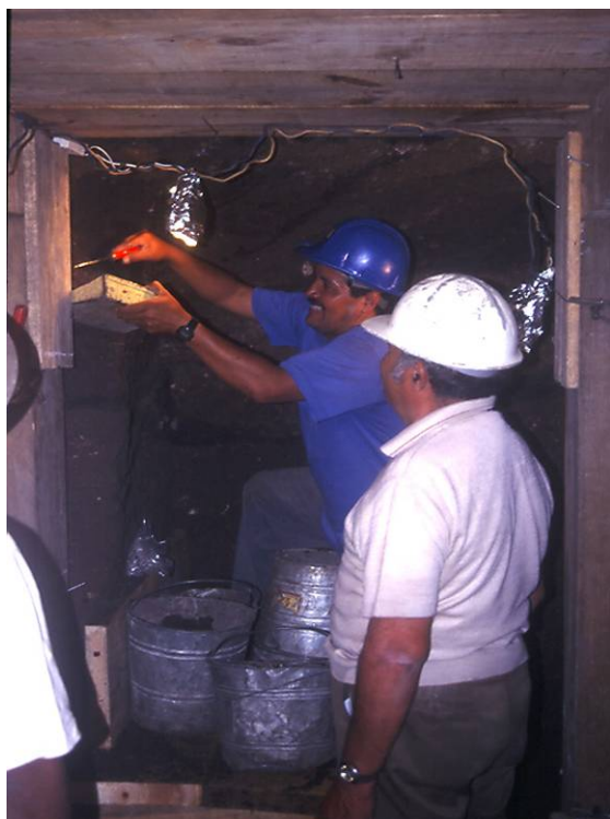
トンネル内部作業
