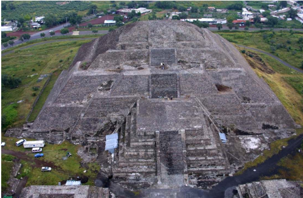
図版1 「月のピラミッド」全景（気球から撮影）。中段・上段の階段手前にトンネルの入り口が見える。
